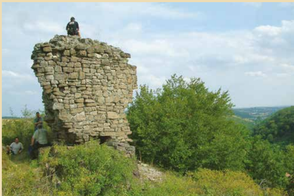
92. kép. Latorvár. Az Őrsur nemzetség lakótornya? A vár okleveles említése nem ismert
