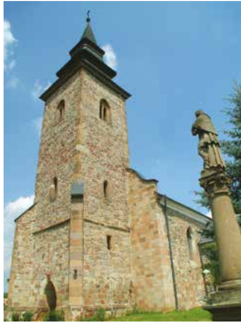
69. kép. A bogácsi középkori eredetű templom
