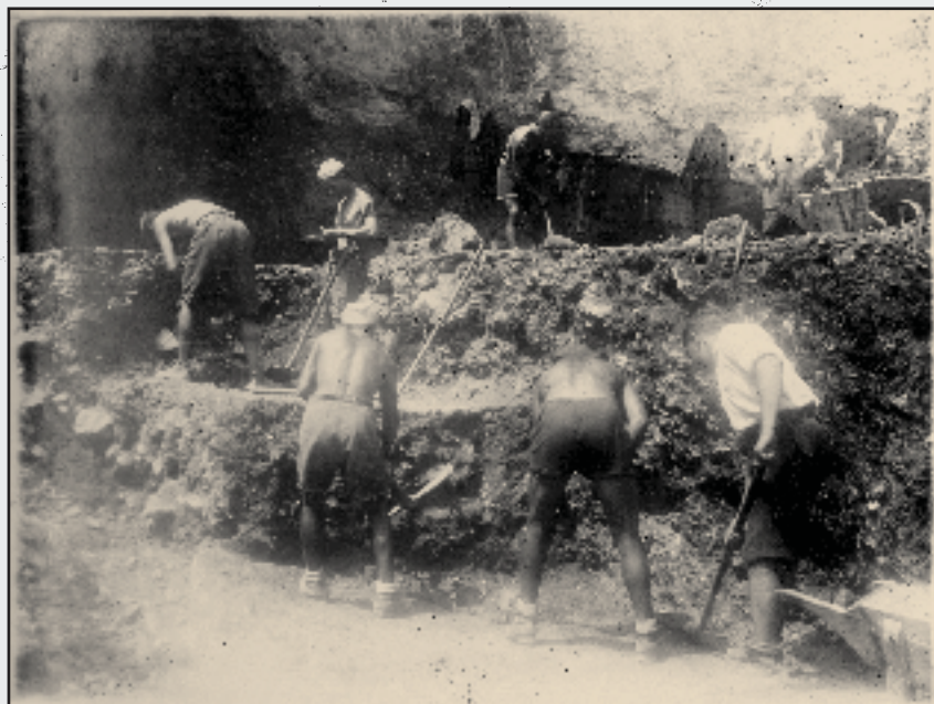
Munka közben A „Csarnok” I. és II. szintjének feltárása Kővár felől
