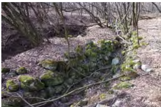
5. kép A hajdani kikövezett falú csatorna mellett vízmosás képződött. Domoszló-Tarjánka (Ny/A) körülkerített területétől délkeletre
